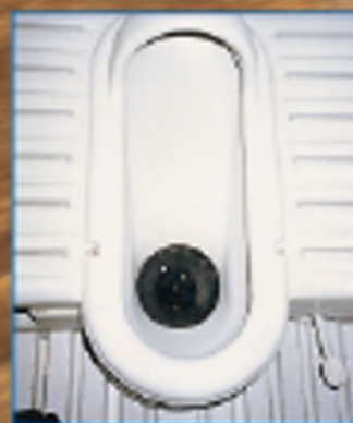
清潔除臭藥水沖洗式便槽
